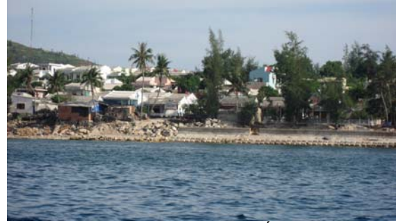
Hình 7. Xói lở và xây kè chống xói lở ở đảo Lý Sơn Fig. 7. Erosion and build embankments against erosion on the island of Ly Son
